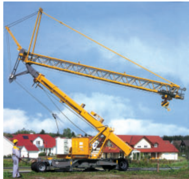
Obr. 3: První fáze dálkového ustavení jeřábu na staveništi
