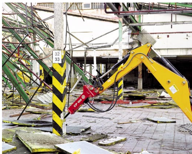
Lehká řada hydraulických bouracích kladiv CHICAGO PNEUMATIC, zkráceně CP
