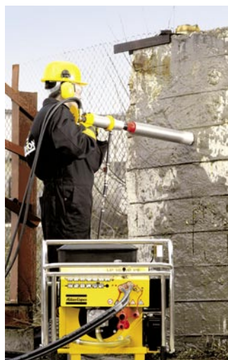
Jádrové vrtačky řady LCD mohou vrtat otvory o průměru až 200mm
