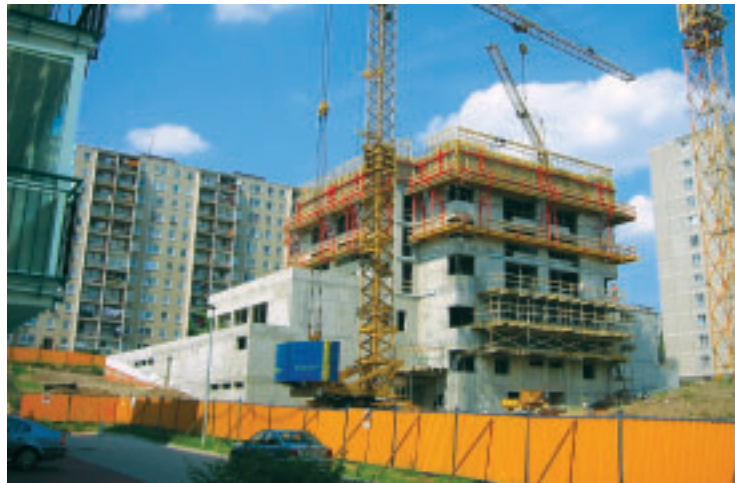
Stavba výškového domu v Praze Modřanech. Dodavatel Průmstav Praha, použito bednění PERI. Zahájení stavby 5. 11. 2001. Dokončení březen 2003.
