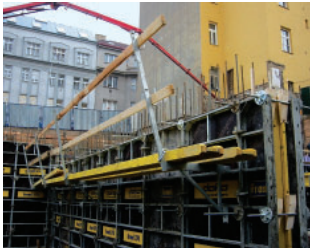
Na českých stavbách oblíbené bednění Doka Framax pro stěny.
