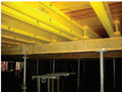
V jednoduchosti je síla – stropní bednění Doka s nosníky H20.
