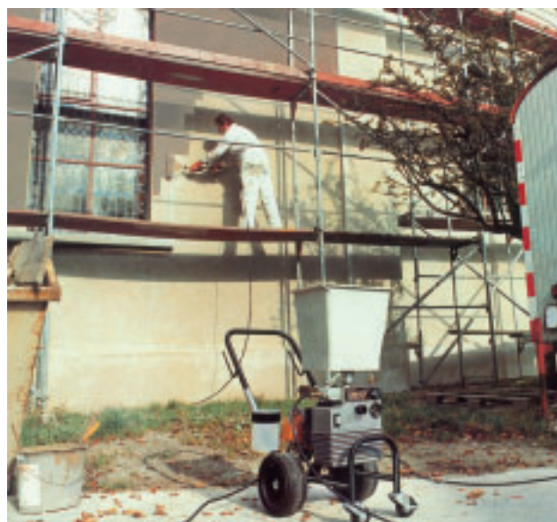
Obr. 7: Použití membránových čerpadel Wagner při válečkování fasády
