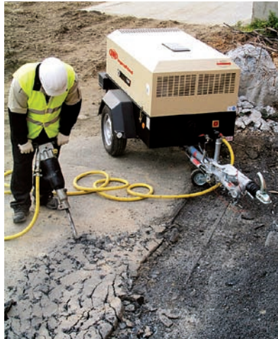
Obr. 2: Mobilní šroubové kompresory s příslušenstvím jako jsou pneumatická sbíjecí kladiva a pneumatické vrtačky reprezentují výrokovou řadu Ingersoll Rand
